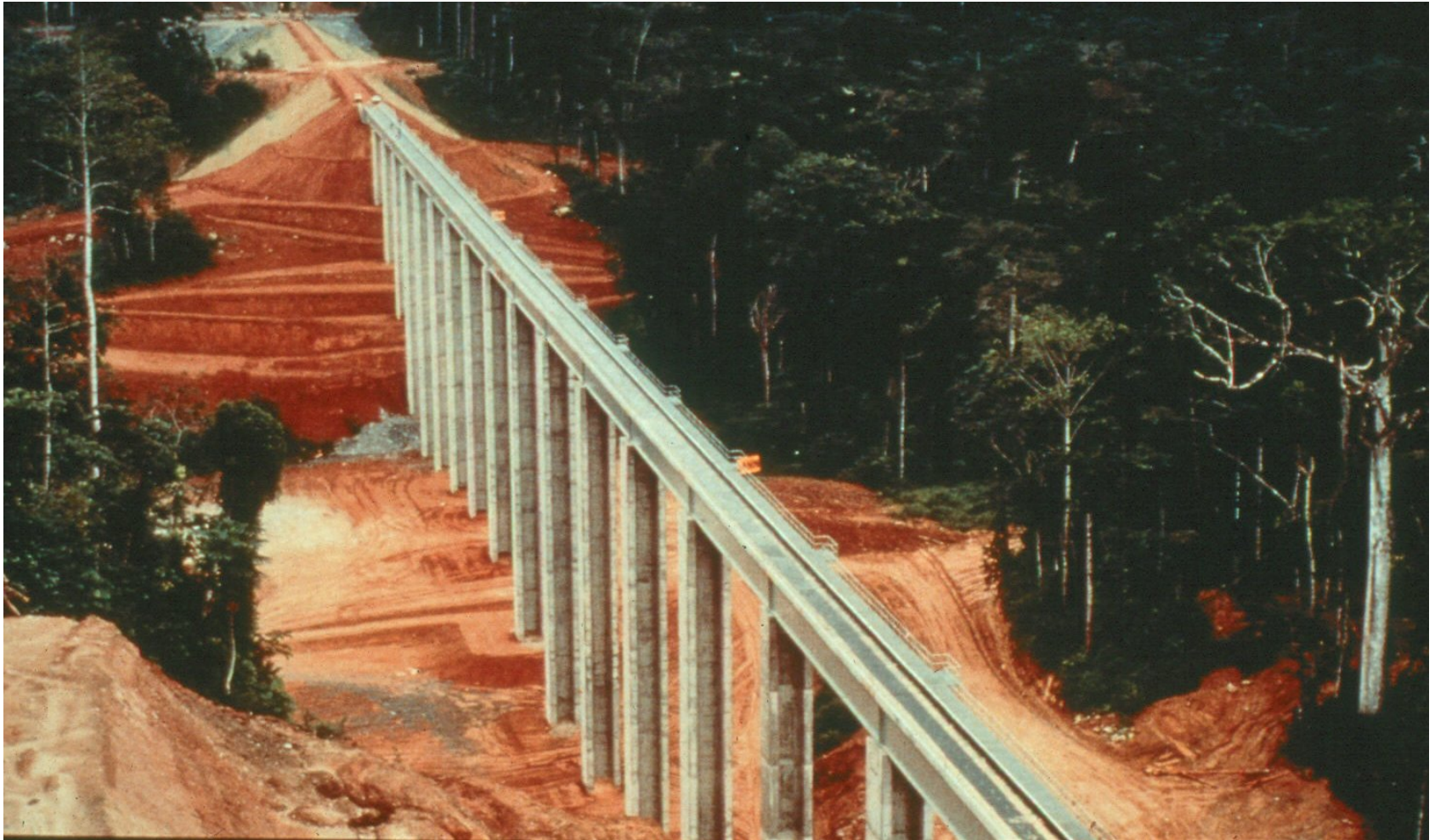
Viaduct au Cameroon utilisation de ciment avec fumée de silice importé du Canada - pour amélioration d'étanchéité
