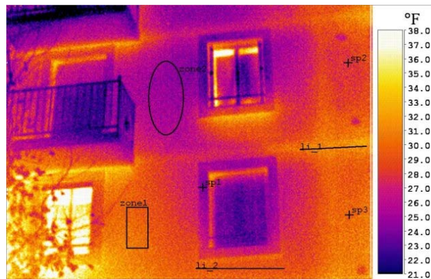
Image thermique d'une façade d'immeuble permettant de localiser les pertes thermiques
